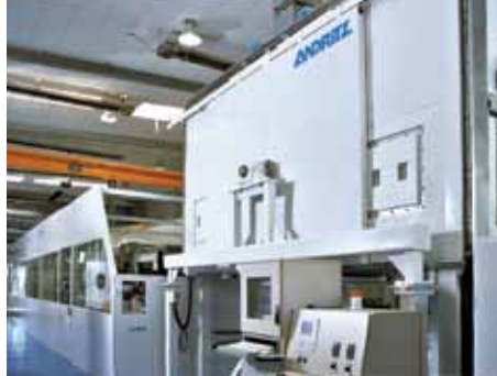
▲ ANDRITZ Perfojet Technical Center in Montbonnot
