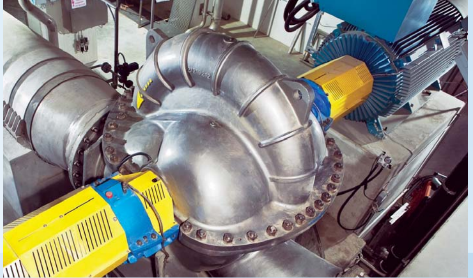
▲ Doppelflutige Spiralgehäusepumpe zur Förderung von Wasser und Suspensionen
