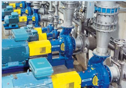
◀ Prozesspumpen zur Förderung von Wasser und Suspensionen für verschiedene Industrien wie die Zellstoff- und Papierindustrie
