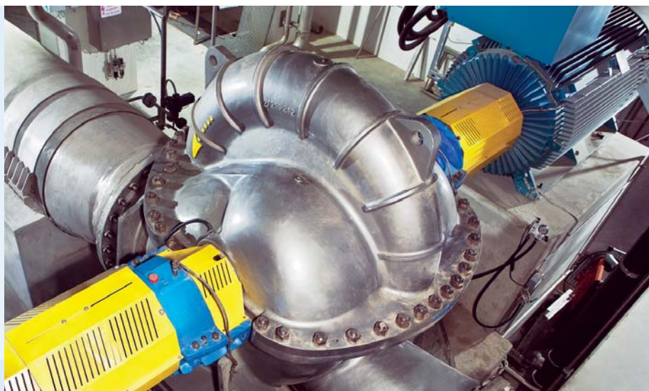
▲ Pompa a doppia aspirazione per pompaggio acqua e sospensioni
